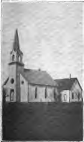
Kirke 1, 1883, ca. $350. Kirke 2, 1891, $3,982. Gravplads, 4 acres. Prestehus 1. Prestehus 2, 1895, ca. $4,000 (ca. $1,000 av dette).
